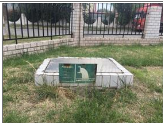
废水总排放口
